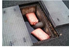
側溝に入れて水面浮上油吸着 (SO-2749)
